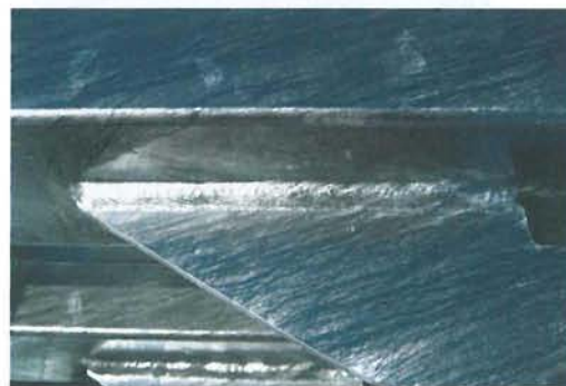
Bild 2 • Metall-Aktivgasschweißnaht an feuerverzinktem Grundwerkstoff – Optimale Oberfläche durch den Einsatz des Schutzsprays.
